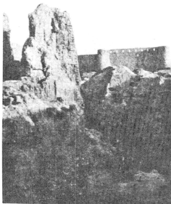
دو برج قلعه طبرک در اصفهان. دید از خندق بیرونی.
