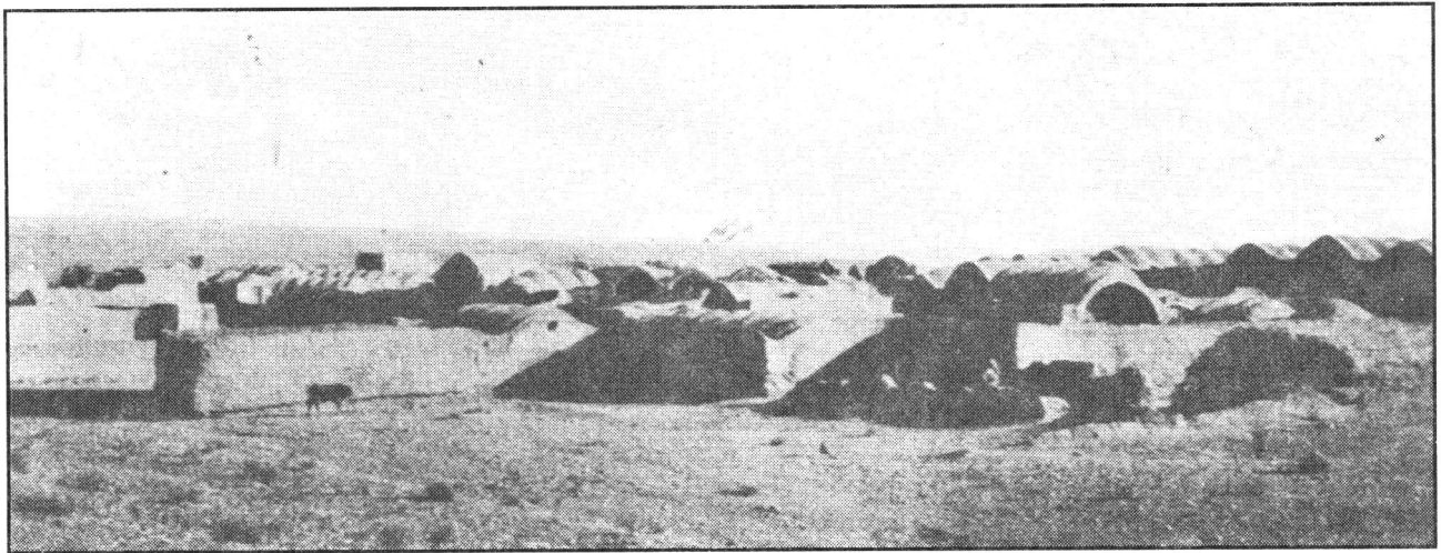
روستایی نزدیک قم. ساخت و ساز خشت و گلی. سقفهای آهنگ و گنبد.
